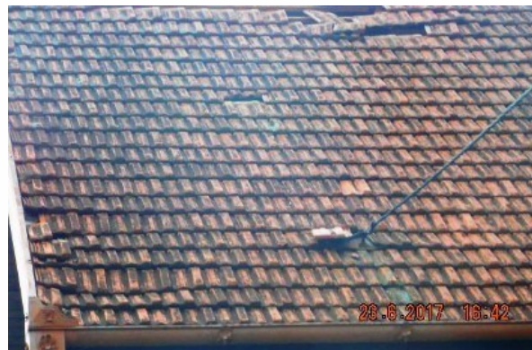
2. Šteta na krovu od oluje – foto iz blizine (zumirano)
